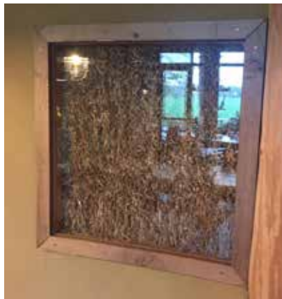
Truth window met muren van stro, afgewerkt met leem in het Biotel in Lievelede
